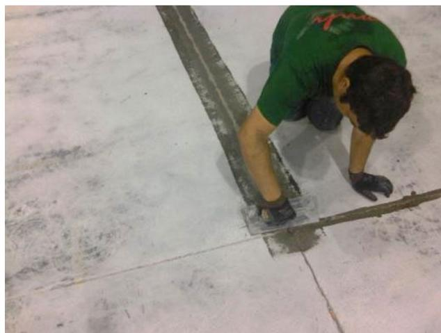
**La incorrecta valoración y tratamiento de juntas de dilatación y fisuras puede reducir la vida útil del pavimento.**
