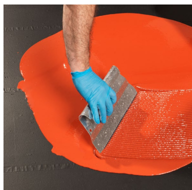
Aplicación del autonivelante a lana dentada
